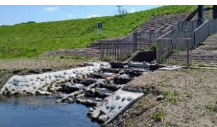
排水管管に魚道を整備
