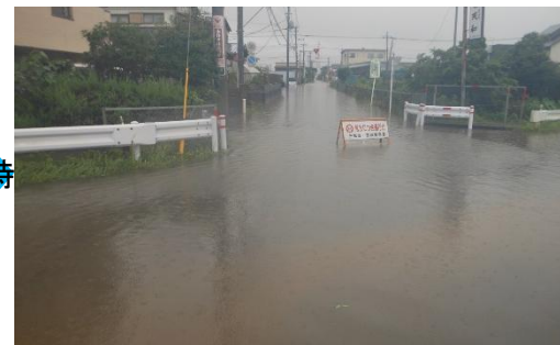
冠水状況(関東・東北豪雨)
