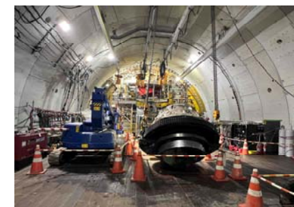
写真③：1次解体状況
