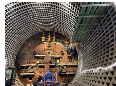
写真⑥：配管・電線類敷設状況
