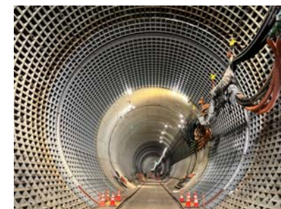
写真⑨：機内覆工完了
