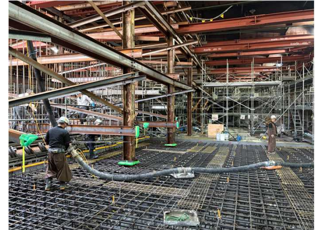
○函渠工<底板Co打設>
