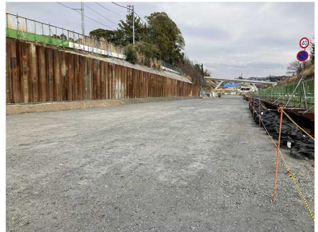
○埋戻し工<埋戻し完了>
