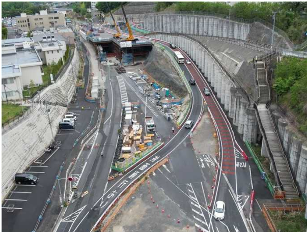
○トンネル終点側全景
