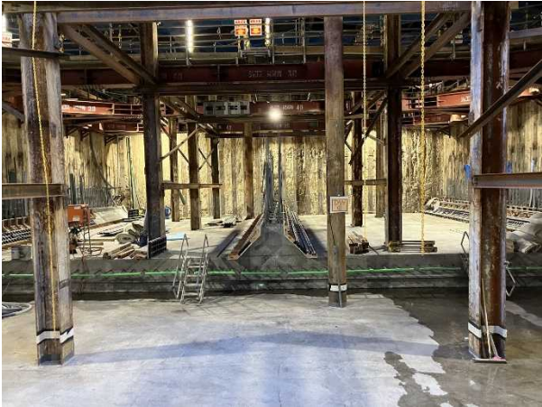
○函渠工<底版Co打設>
