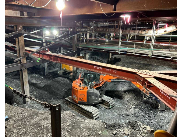
○下り線 掘削状況
