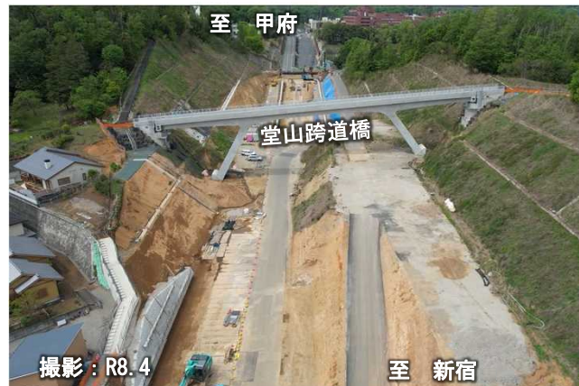
写真② 館地区改良工 状況
