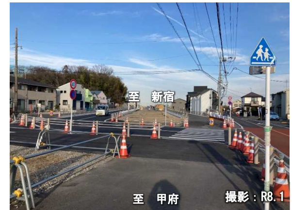
写真② 川辺堀之内地区改良工
