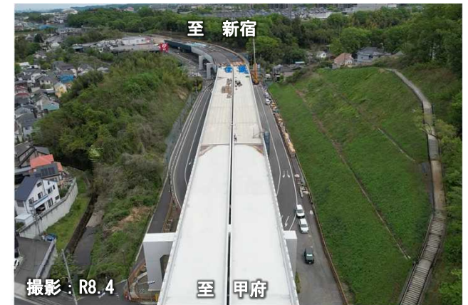
写真③ 大船寺田高架橋 状況
