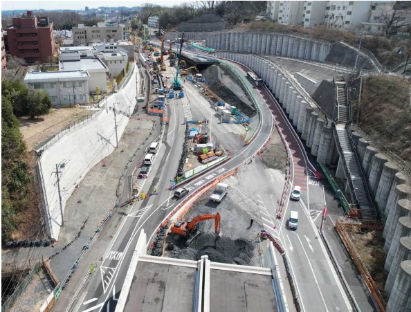
○トンネル終点側全景
