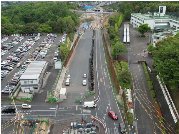
○トンネル起点側全景
