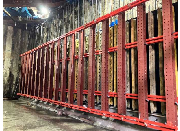
○函渠工<側壁部型枠組立>
