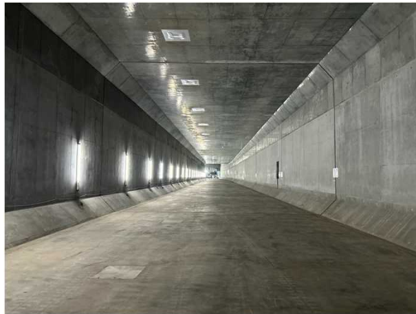
○函渠工<函渠内空全景>
