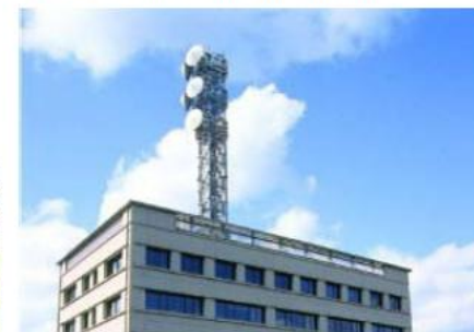
防災拠点の整備 (多重無線装置の整備)
