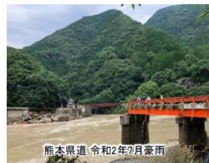
橋梁流出の被災事例
