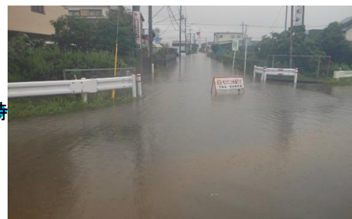
冠水状況(関東・東北豪雨)
