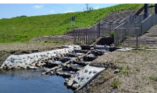
排水管に魚道を整備
