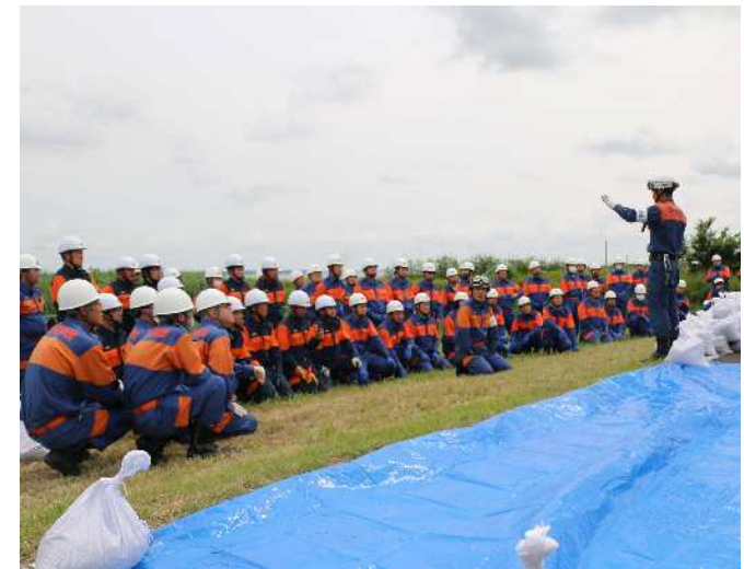
(改良積み土のう工法)
