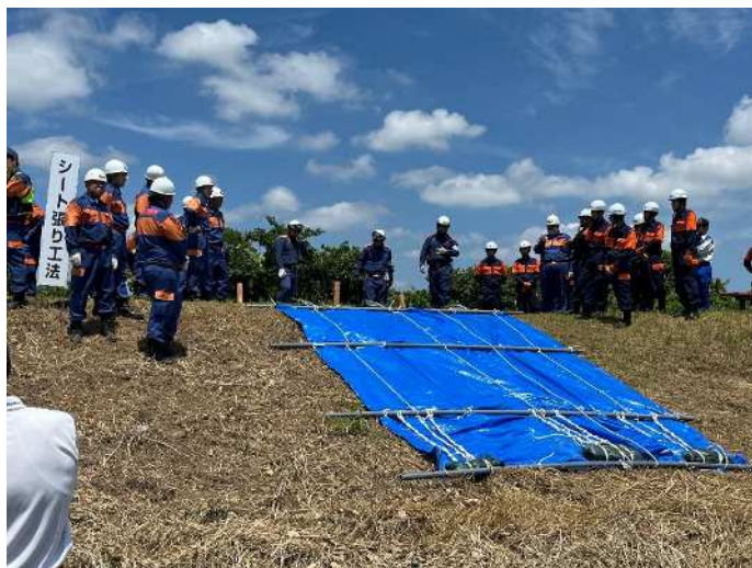
(シート張り工法)
