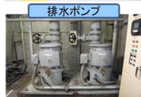
地下への浸水防止対策
