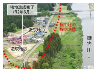
移転先宅地造成完了状況
