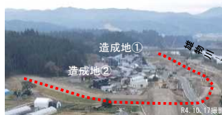
移転家屋の建設が進む状況
