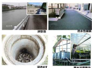
雨水貯留浸透施設の例
