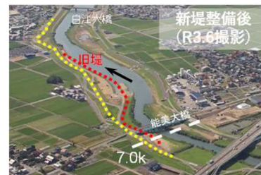
引堤(石川県梯川水系梯川)
