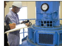
(ポンプの点検整備)
