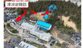
津波避難路となっている山地の被災
