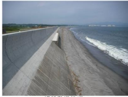
堤防整備状況
