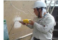
老朽化した施設の機能診断
