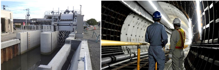
雨水ポンプ場の整備
