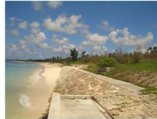
緩傾斜護岸の整備状況
