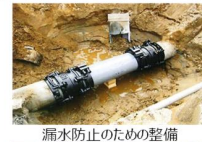
漏水防止のための整備
