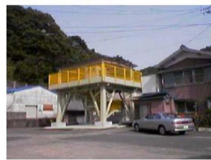
○避難タワーの設置
