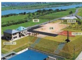
○防災ステーションの上屋整備
