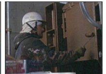
(ゲートの塗装)
