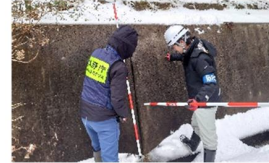
激甚災害後の治山施設の点検支援
