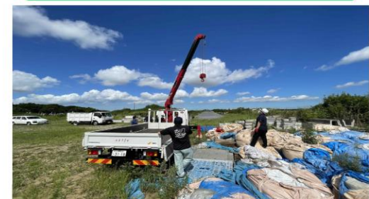
※土のう補充作業
