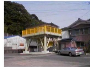
○避難タワーの設置
