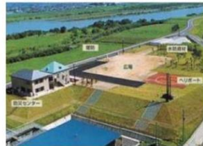
○防災ステーションの上屋整備
