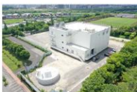
雨水ポンプ場
