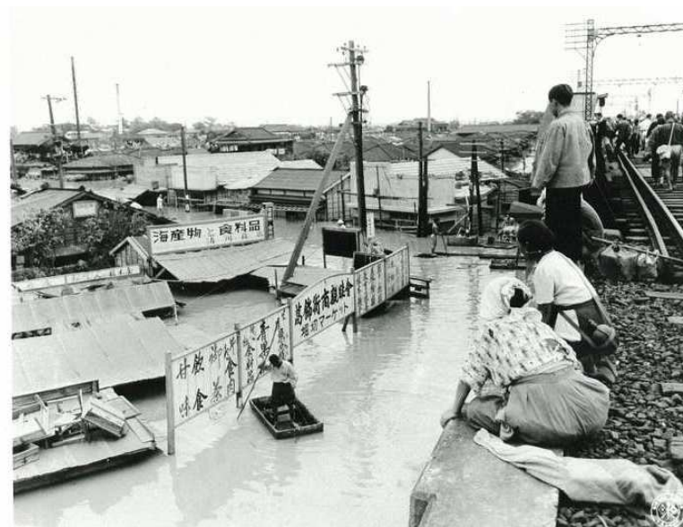
葛飾区堀切付近における浸水の状況
