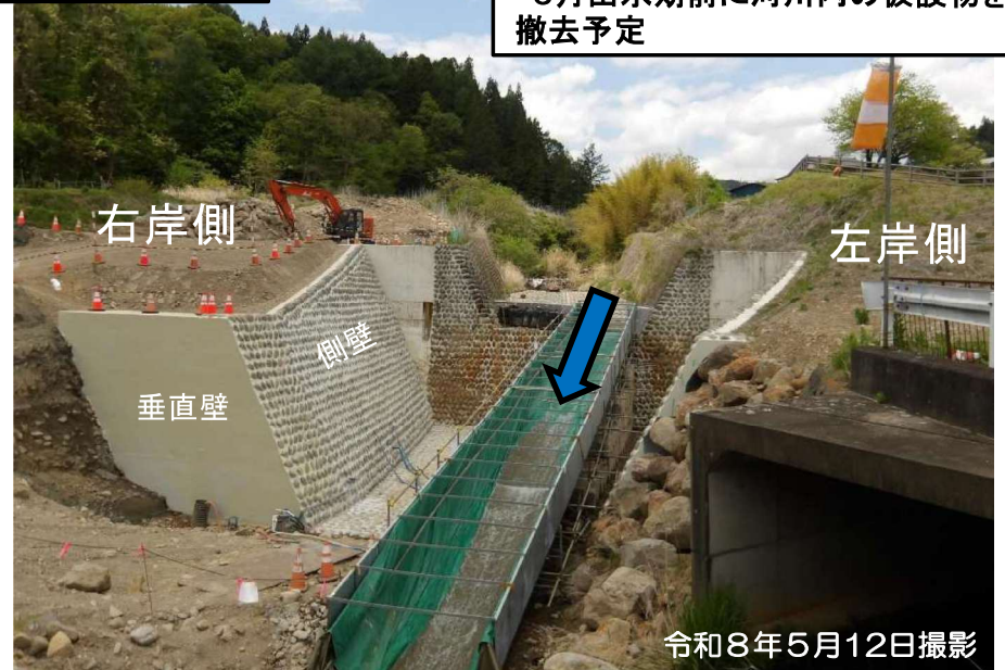
①左岸側施工完了
