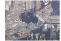
埼玉県八潮市の事故現場(令和7年1月31日)
