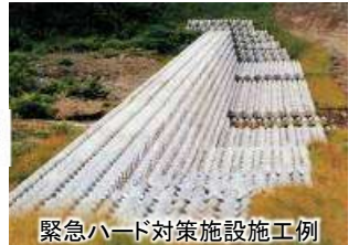
緊急ハード対策施設施工例
