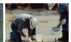
護岸コンクリート補修
