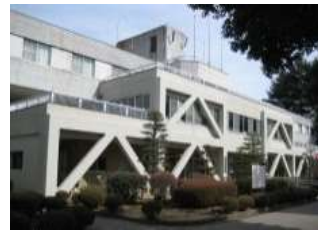
総合運動公園事務所 （栃木県）
