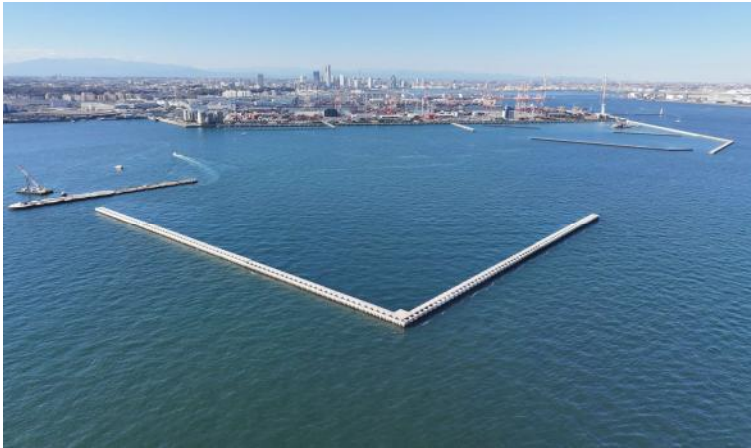
横浜港新本牧ふ頭ハイブリットケーソン据付 (令和8年1月)
