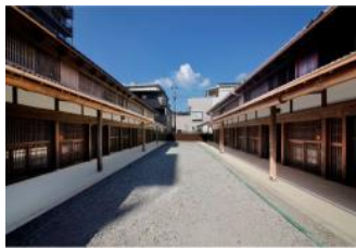
街なみ環境整備事業 （埼玉県川越市）
