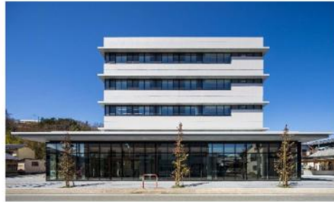
富士川地方合同庁舎
