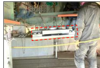
支承受替例(国道50号 米沢高架橋)
