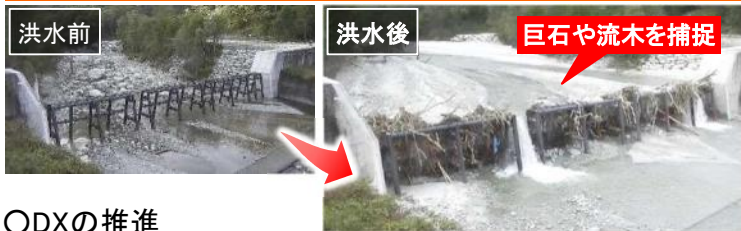
砂防堰堤の効果(令和元年東日本台風:山梨県白川)
