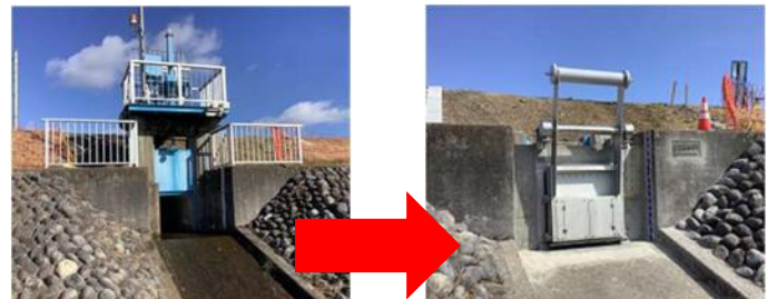
大久保排水樋管(鬼怒川)のゲート更新前(左)と更新後(右)
