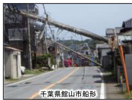
千葉県館山市船形 台風等による電柱倒壊状況
