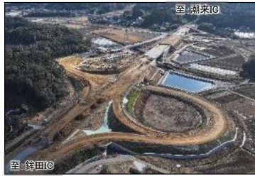
施工状況(北浦IC)
