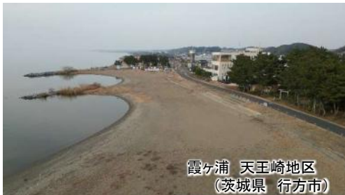
霞ヶ浦 天王崎地区 (茨城県 行方市) 養浜による天王崎らしい広々とした砂浜景観の形成
