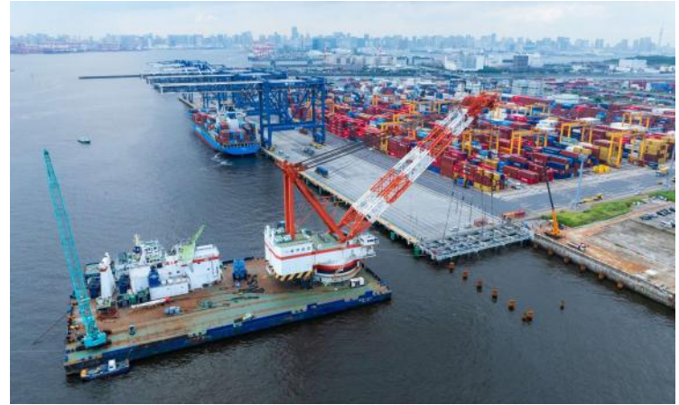
東京港中央防波堤外側コンテナふ頭Y3岸壁ジャケット据付 (令和7年6月)
