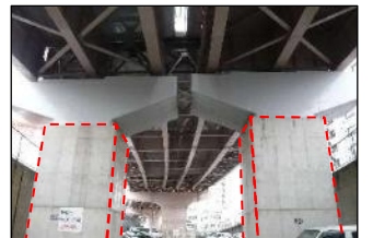
耐震補強例(国道4号 梅田立体橋)
