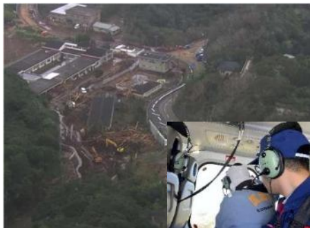
被害状況(土砂流出)調査 (東京都八丈町)
