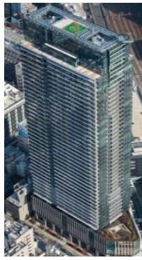
横浜駅きた西口鶴屋地区 第一種市街地再開発事業 （神奈川県横浜市）
