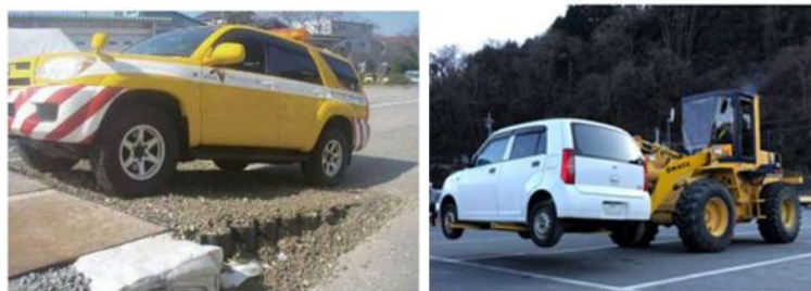
道路啓開の状況(訓練) (左:橋梁段差の解消 右:路上放置車両の移動)
