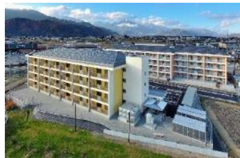
公営住宅整備事業 （長野県）
