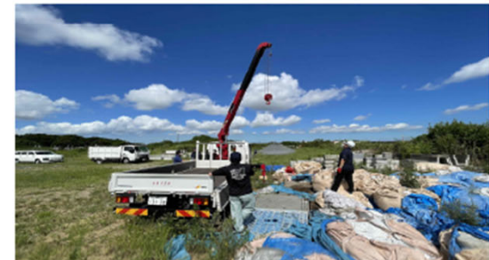
※土のう補充作業
