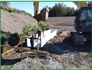
堤外水路を設置しています
