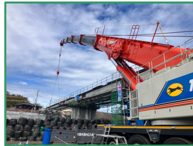
主桁の架設を行っています
