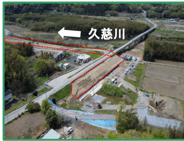
工事箇所の全景（上流から）
