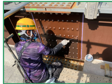
主桁の塗装を行っています
