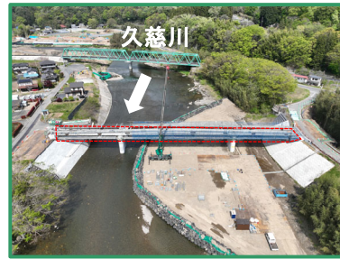
工事箇所の全景（下流から）
