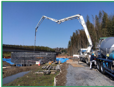
函渠のコンクリートを打設しています
