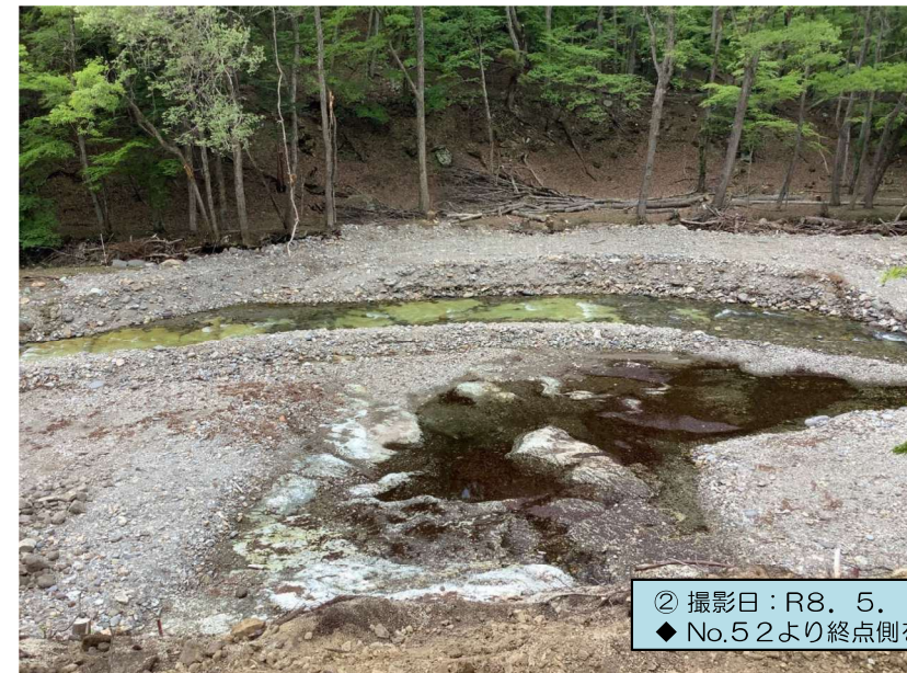
① 撮影日：R8. 4. 23 ◆No.21より終点側を望む
