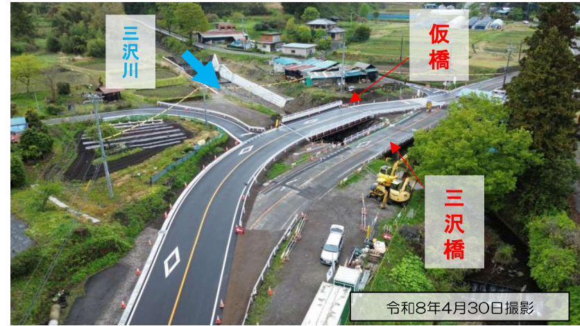
三沢橋を上空から
