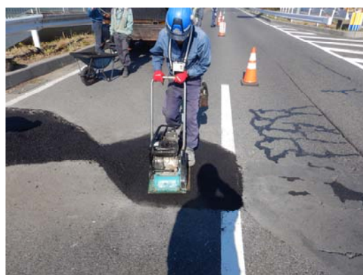
【路面補修作業】
