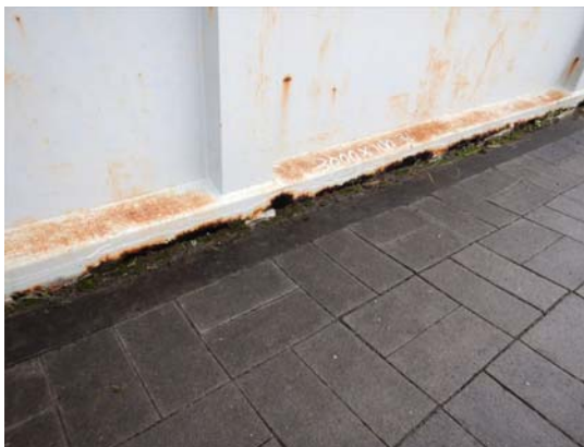
・地覆の腐食 <地覆補修>
