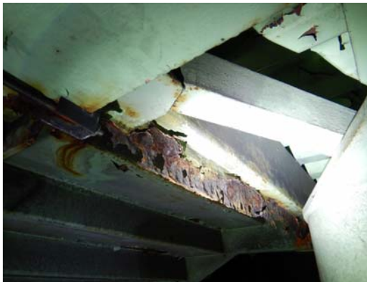
・地覆の腐食 <地覆補修>
