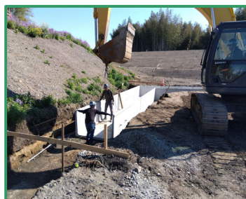
堤外水路を設置しています
