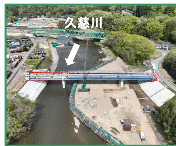
工事箇所の全景（下流から）
