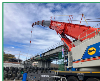
主桁の架設を行っています
