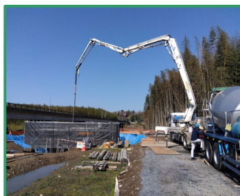
涵渠のコンクリートを打設しています
