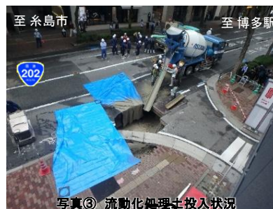
写真③ 流動化処理土投入状況
