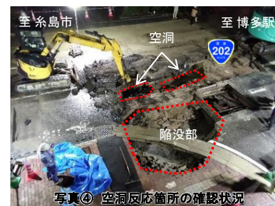
写真④ 空洞反応箇所の確認状況
