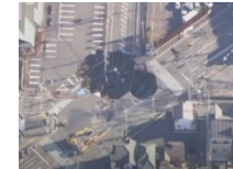
埼玉県八潮市の事故現場(令和7年1月31日)
