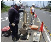
(貫入試験による調査)
