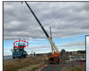
▲老朽化したゲート開閉装置の撤去状況
