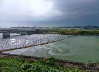
河川等へのアオコの遡上を防止するため、アオコフェンスの設置を行う
