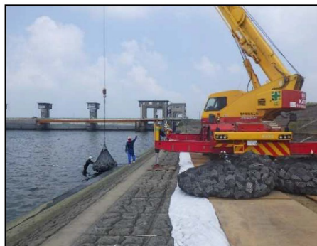
常陸川の護岸補修状況(袋詰根固め設置)
