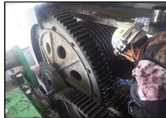
河川管理施設の設備点検(水門)
