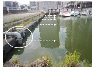
土浦港内の湖水を循環させ、アオコの遡上や集積を防止するために土浦港送水ポンプ設備の運転を行う
