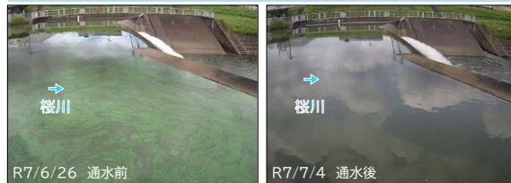
桜川・柳堤堰の状況
