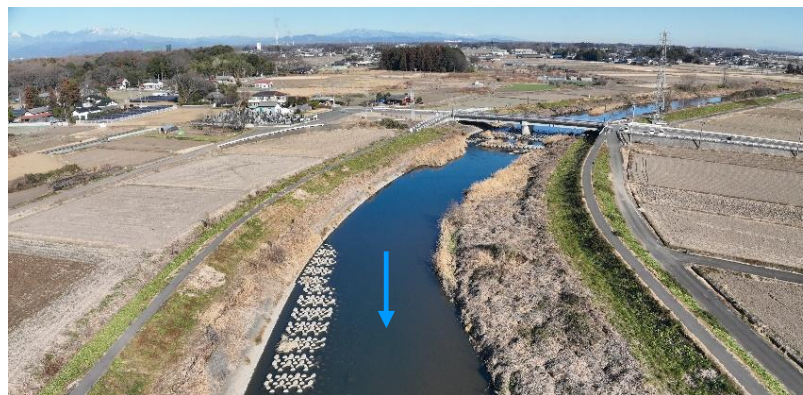
UAVを活用した目視点検
