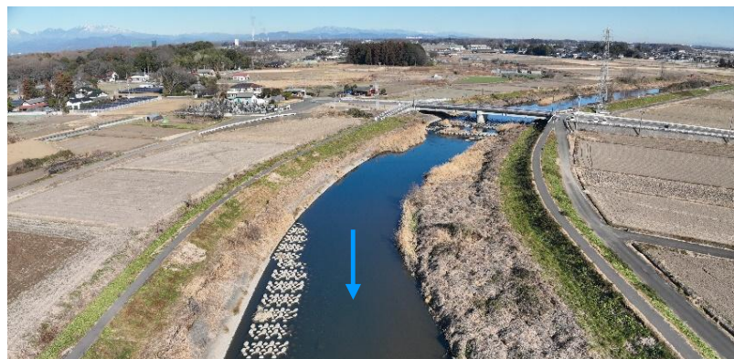
UAVを活用した目視点検
