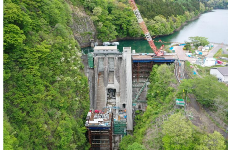
【水門据付工(放流管据付)】 （撮影日：R8.4.23）
