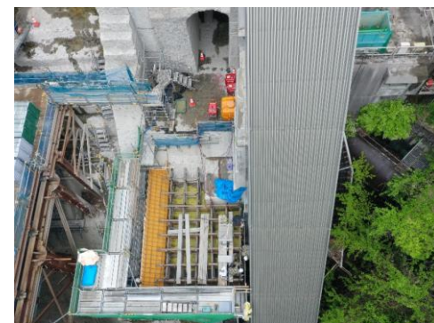
【小容量放流設備操作室(型枠設置)】 （撮影日：R8.4.30）
