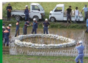
平成19年群馬県明和町で作られた釜段工
