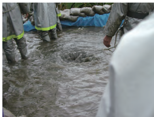
平成13年埼玉県加須市で発生した漏水の様子
