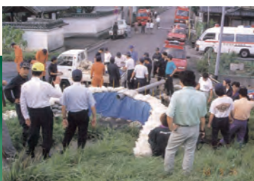
平成10年群馬県明和町で作られた月の輪工
