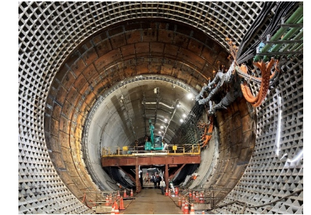
写真⑦：2次解体完了
