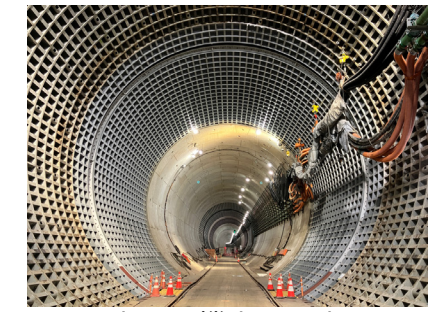
写真⑨：機内覆工完了
