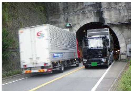
ゆとりのないすれ違い(既設トンネル)
