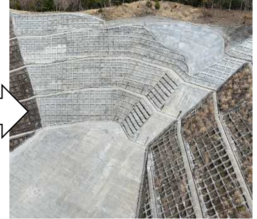
本復旧工事完了後
