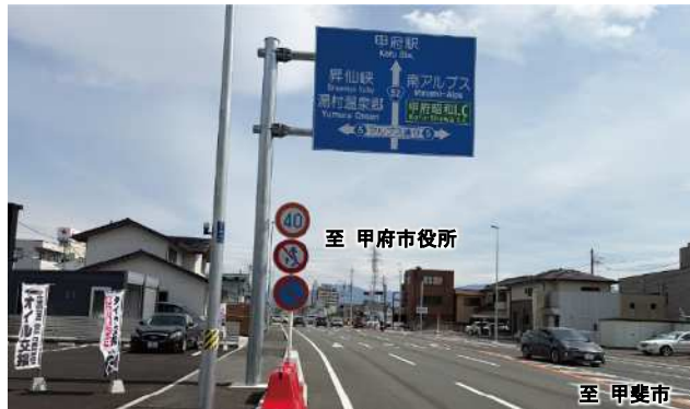
② 4車線化後の状況1
