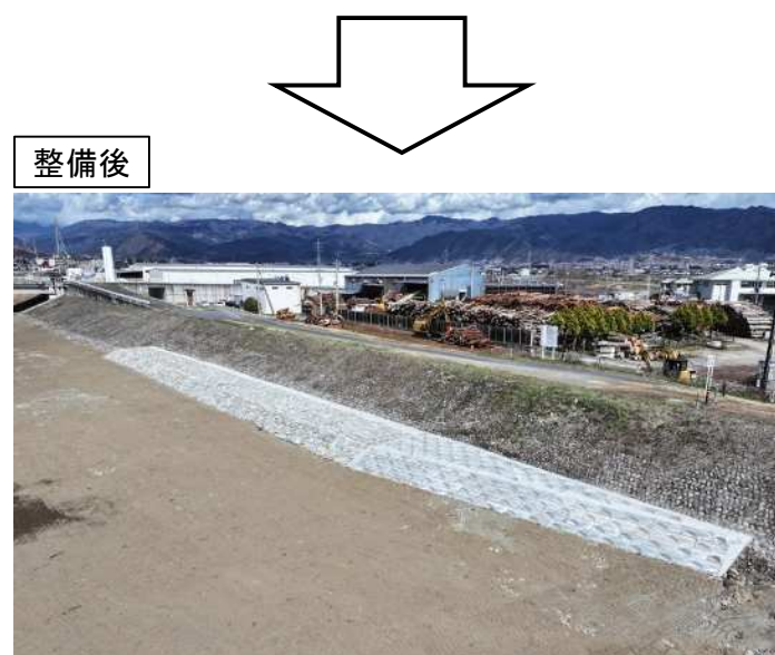
令和7年度完成箇所
