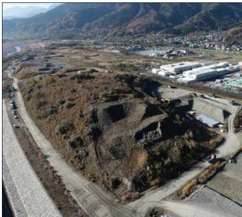
下山地区(トンネル残土仮置き場)
