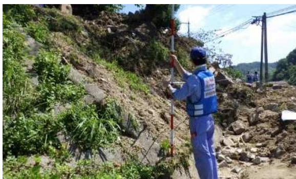
被災状況調査
