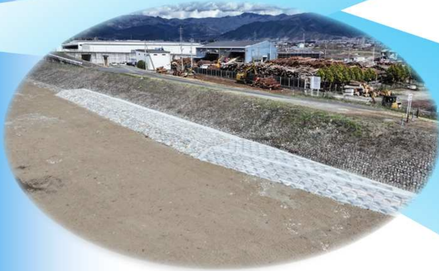
笛吹川 大野地区護岸整備
