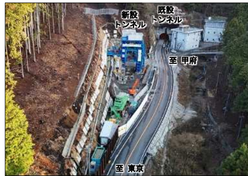
大月市側坑口(トンネル掘削ヤード)
