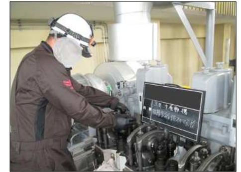
機械設備の点検
