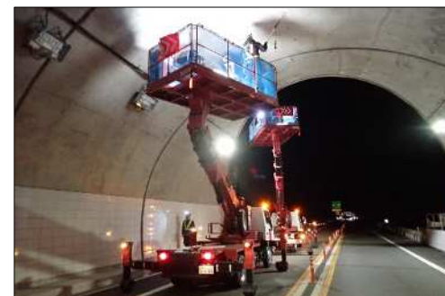
トンネル点検
