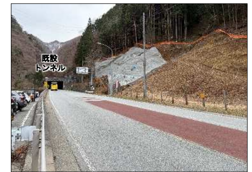
甲州市側坑口の工事状況
