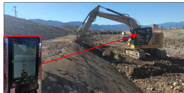
ICT建設機械による施工（笛吹川）
