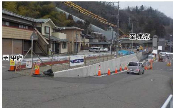
② 施工状況(全景)
