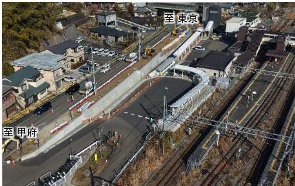
① 施工状況(全景)
