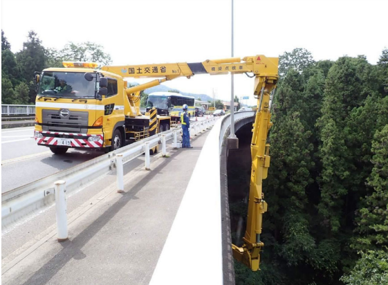
橋梁点検車による点検状況（湯舟橋）
