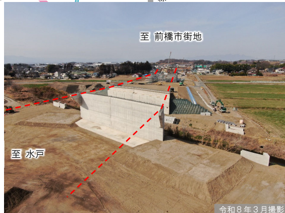
②伊勢崎市野町の橋梁下部工事施工状況
