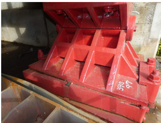
— 新三国大橋（支承補修） —
