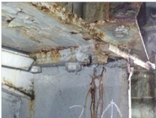
— 渋川上白井綾戸（横梁部補修） —
