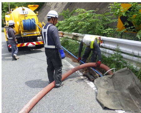
道路清掃状況
