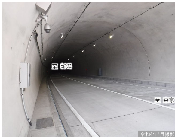
②新三国トンネル内部の状況
