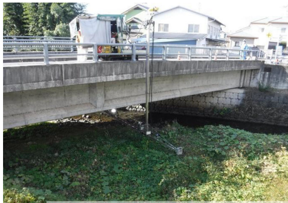
橋梁点検支援ロボットを活用した 橋梁点検状況（第二桃ノ木橋側道橋(下)）
