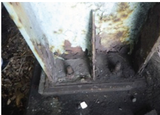
— 渋川上白井綾戸（柱基部補修） —
