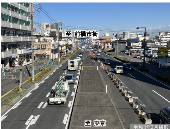
①桃井虹色橋から前橋市街地方面の状況
