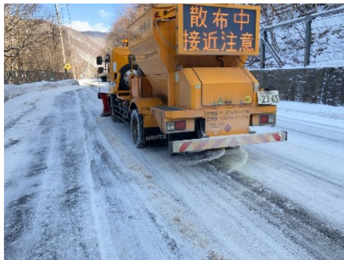
凍結防止剤散布状況
