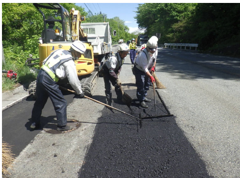
舗装補修状況
