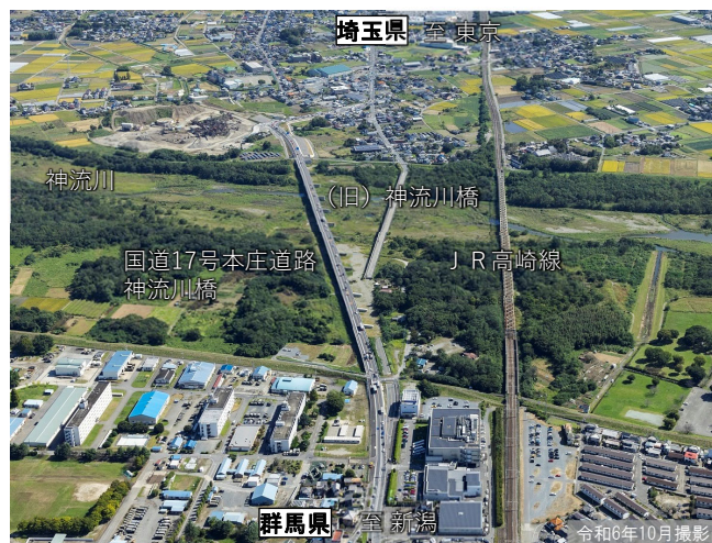
神流川橋付近の状況
