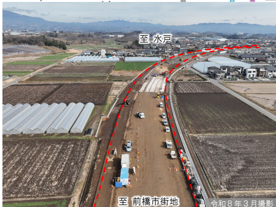
①伊勢崎市赤堀今井町の改良工事施工状況
