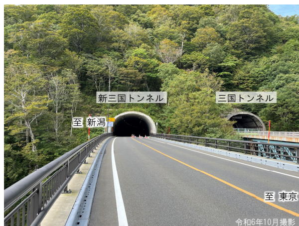
①新三国トンネルの状況
