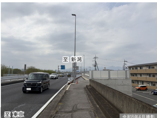
①拡幅区間の交通状況
