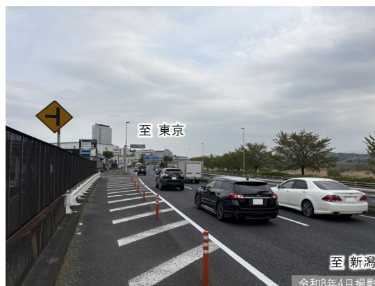
②和田橋交差点オフランプ部の混雑状況
