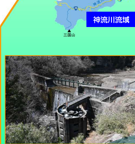
上木馬瀬砂防堰堤 (流木止め設置)
