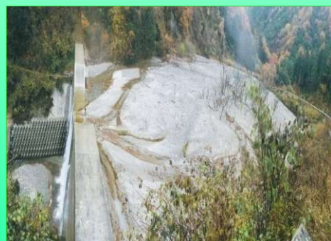
土砂を捕捉した砂防堰堤
