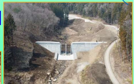
内手川第二砂防堰堤
