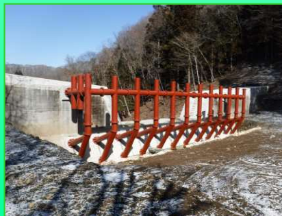
二又上流第二砂防堰堤（改築）
