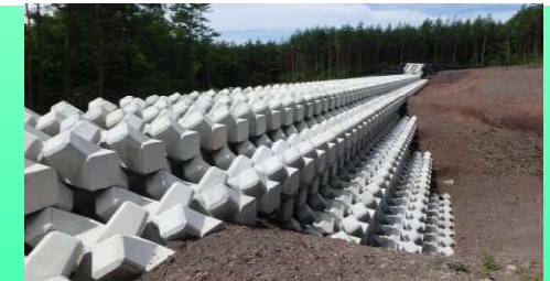
コンクリートブロックを用いた砂防堰堤
