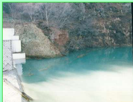
土砂捕捉前の砂防堰堤
