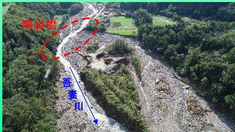
嬭恋村長井川原(鳴岩橋落橋)
