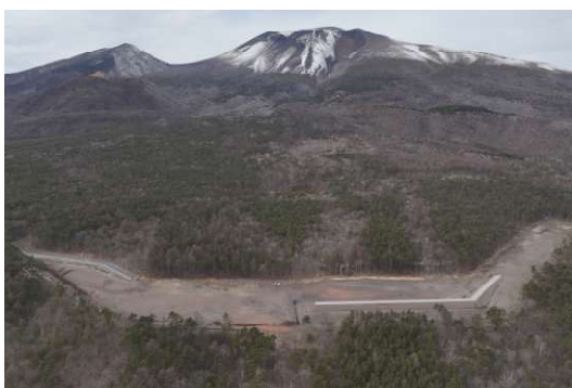
大日向川砂防堰堤
