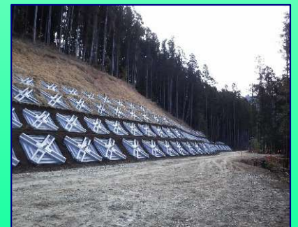
譲原アンカー工
