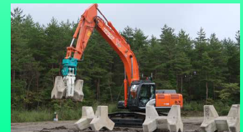
遠隔操作による無人化施工
