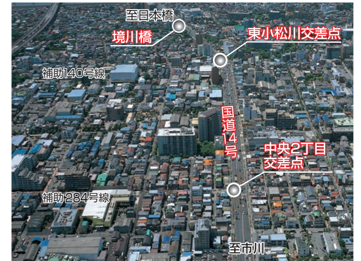
▲江戸川区東小松川および中央2丁目交差点付近
