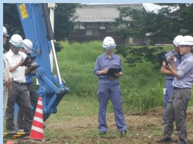
LiDARによる出来形計測実習
