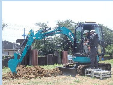
ICT建設機械による施工実習（写真右：小規模土工向け小型バックホウ）
