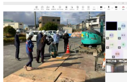
床付け面土質確認
