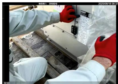
現場での機器搬入状況
