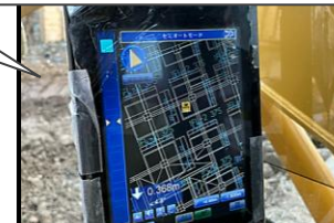
モニターによる管理の状況
