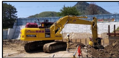
土工事の状況
