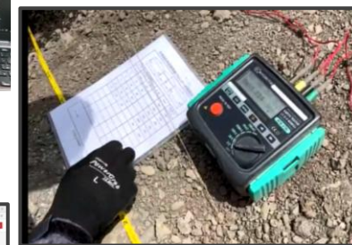
現場確認状況(設備)web
