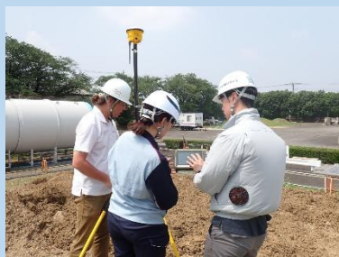
3次元計測機器による起工測量実習
