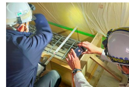
設備基礎配筋検査場面の共有状況
