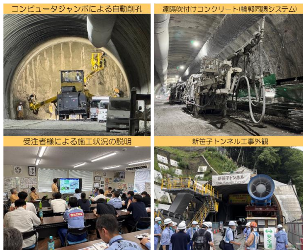
安全かつ熟練度に依存しない施工環境を整備
