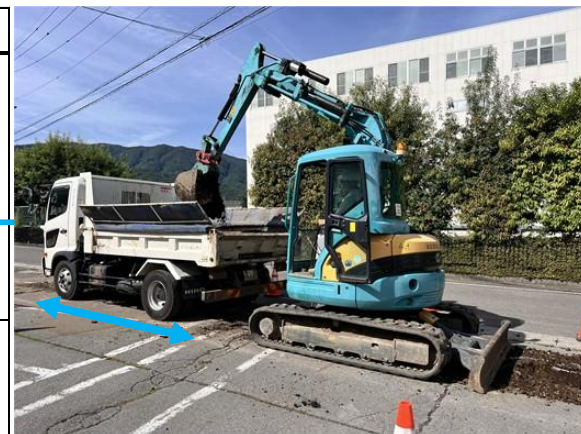
水道管敷設工事における掘削作業
