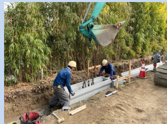
側溝を施工しています。 (令和8年1月)
