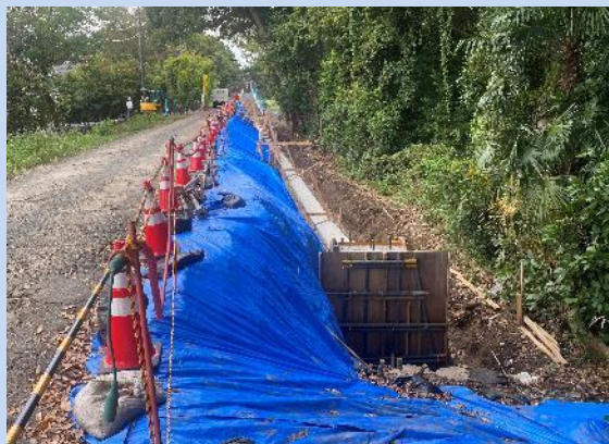
擁壁の基礎を打設しています。 (令和7年9月)
