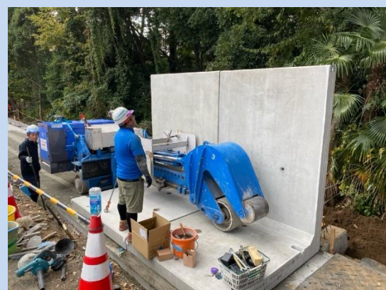
擁壁を設置しています。 (令和7年11月)
