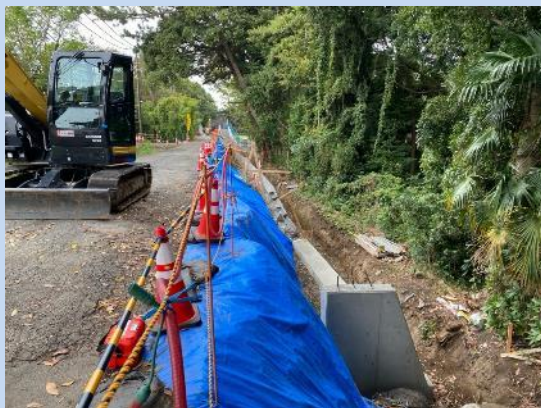
擁壁を設置しています。 (令和7年10月)
