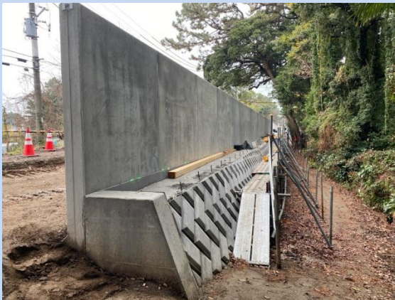
護岸を施工しています。 (令和7年12月)
