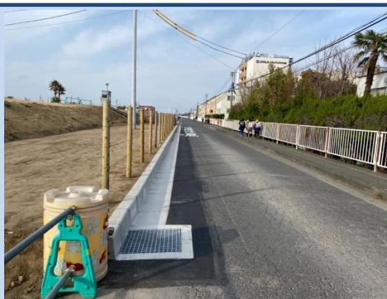
側溝を施工しています。 (令和8年2月)
