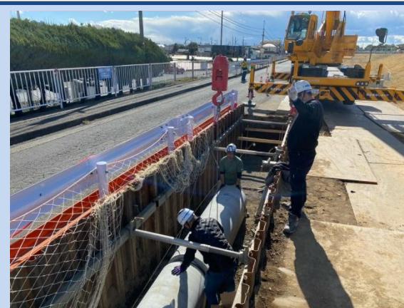
側溝を施工しています。 (令和8年1月)
