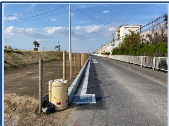
工事が完了しました。 (令和8年3月)
