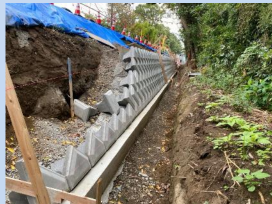
擁壁を設置しています。 (令和7年10月)
