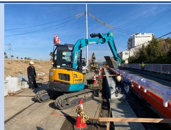
側溝を施工しています。 (令和8年2月)
