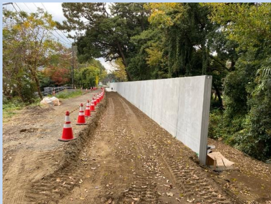
擁壁を設置しています。 (令和7年11月)
