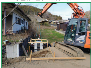
集水枡を設置しています
