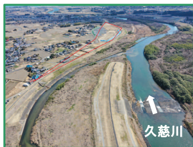
工事箇所の全景（上流から）
