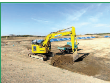
築堤のための表土のすき取りをしています
