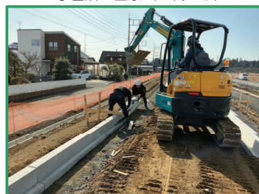
歩行道ブロックを設置しています
