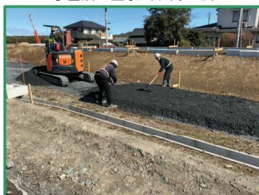
砕石舗装の敷均しをしています
