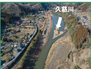
工事箇所の全景（下流から）
