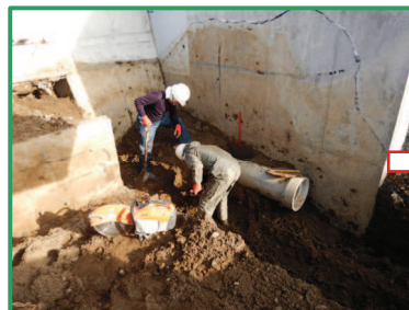
U型側溝を排水施設に接続しています
