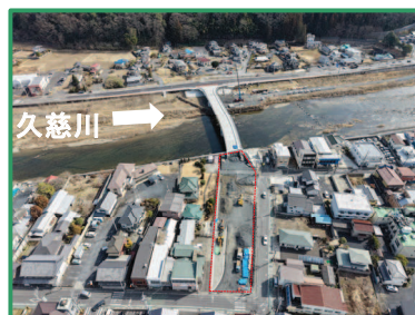
工事箇所の全景（右岸側から）
