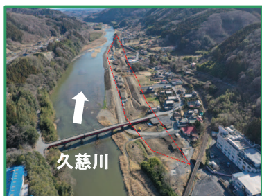
工事箇所の全景（上流から）
