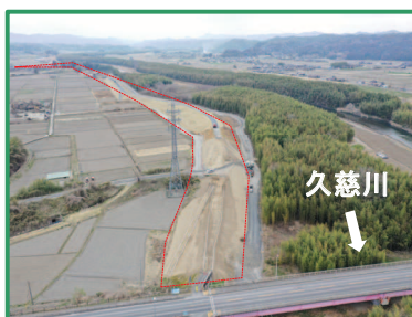
工事箇所の全景（下流から）
