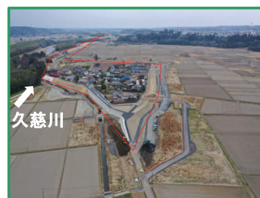
工事箇所の全景（上流から）
