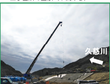
連節ブロックを設置しています
