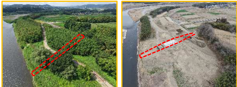
工事箇所施工前
