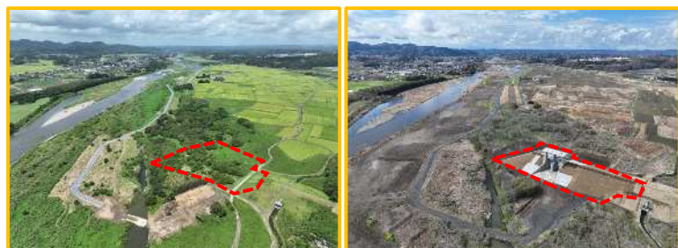
工事箇所施工前
