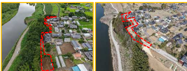
工事箇所施工前
