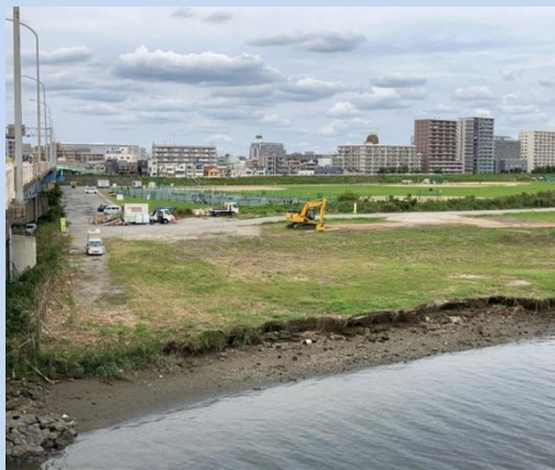
施工箇所の除草を行っています。 (令和7年9月)
