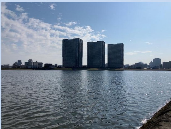
工事が完了しました。 (令和8年3月)
