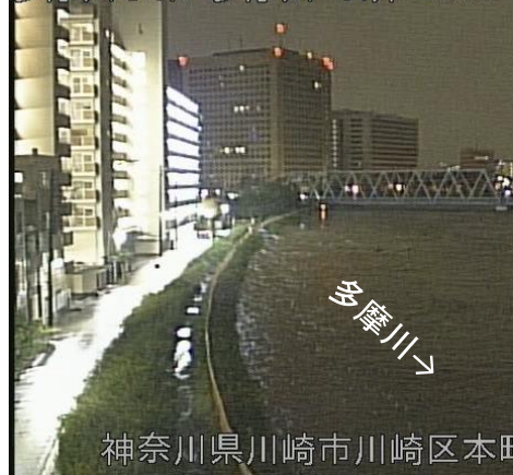
令和元年東日本台風の状況
