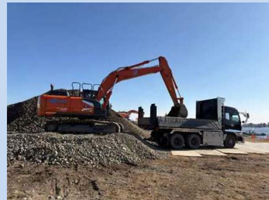
浚渫した土砂の積込を行っています。 (令和8年1月)
