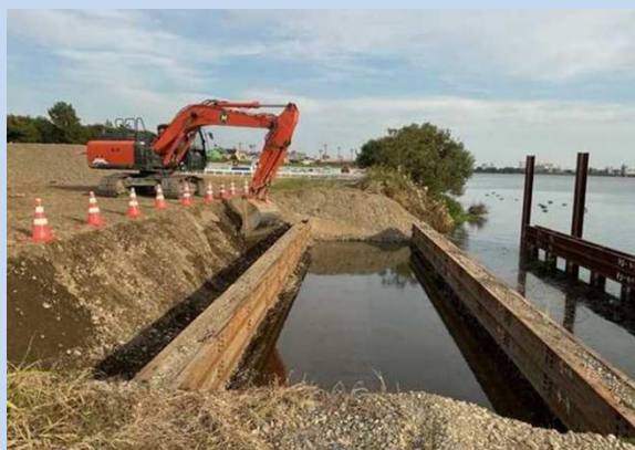
仮橋を設置しています。 (令和7年11月)
