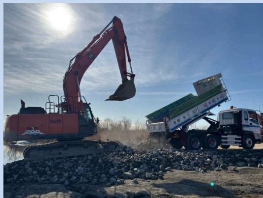
土砂を運搬しています。 (令和8年2月)
