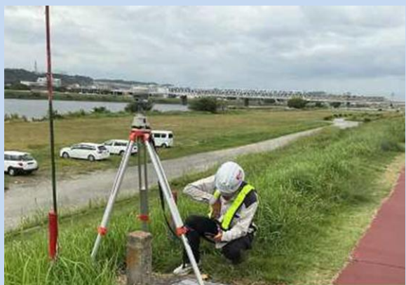
工事に入る準備をしています。 (令和7年10月)
