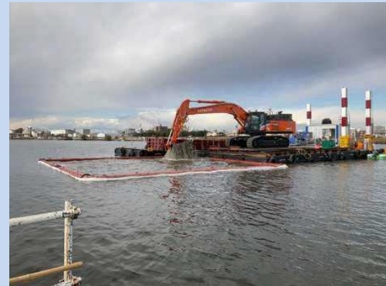
浚渫を行っています。 (令和7年12月)
