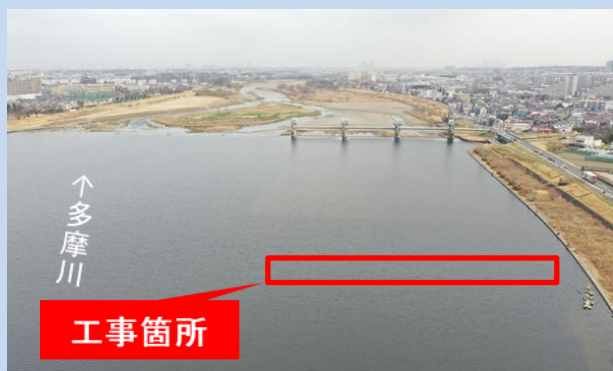
工事が完了しました。 (令和8年3月)
