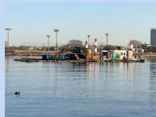
浚渫を行っています。 (令和8年1月)
