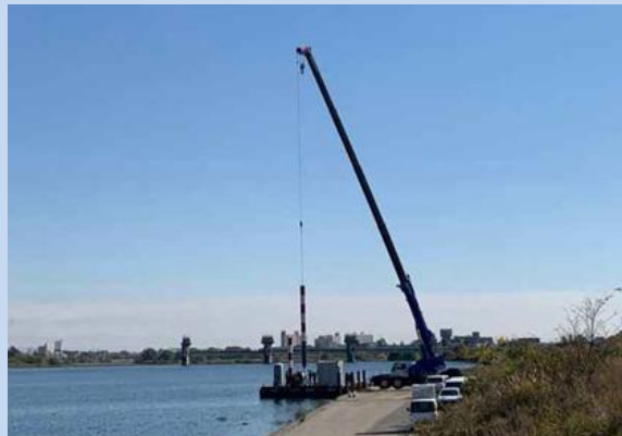
作業船の組立を行っています。 (令和7年11月)
