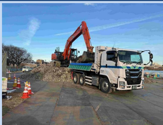
土砂を運搬しています。 (令和8年2月)
