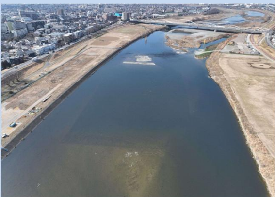
工事が完了しました。 (令和8年3月)
