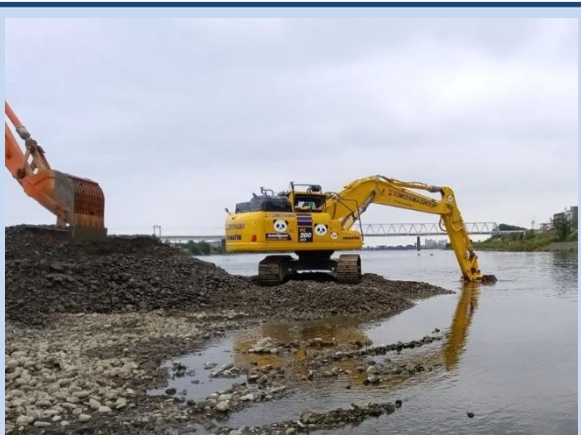
河道を掘削しています。 (令和7年10月)
