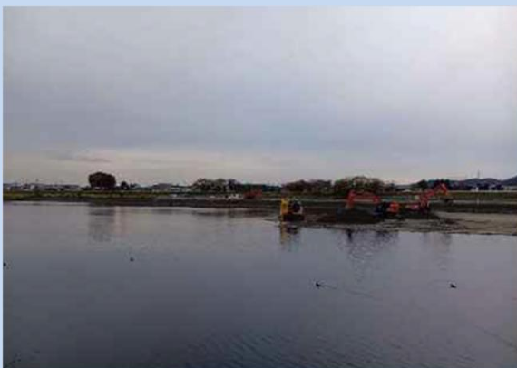
河道を掘削しています。 (令和7年11月)
