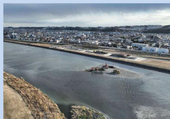
河道を掘削しています。 (令和8年1月)
