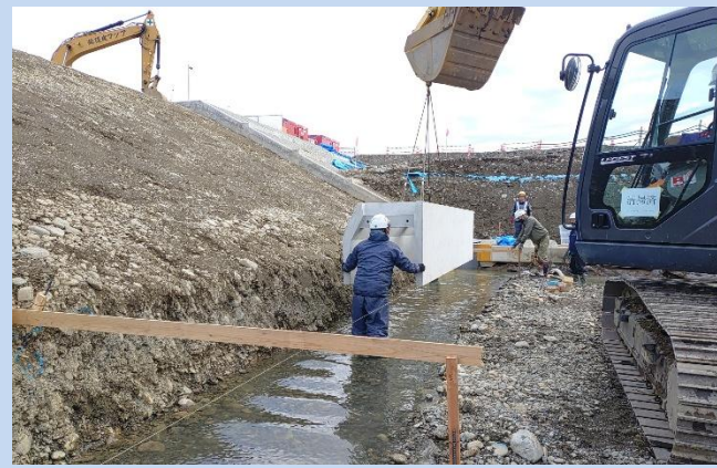
ブロックの据付をしています。 (令和7年12月)
