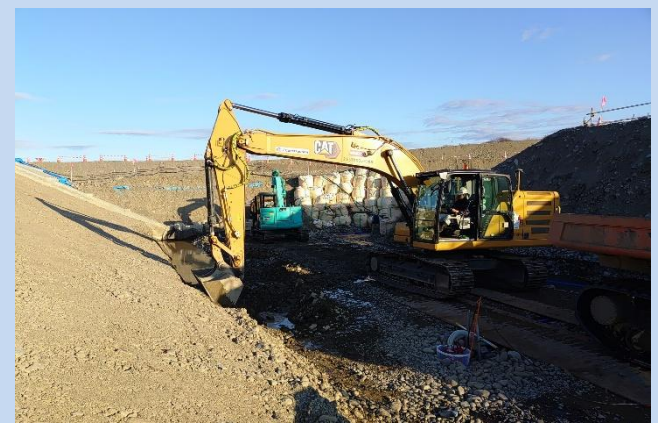
ブロックの据付をしています。 (令和7年12月)
