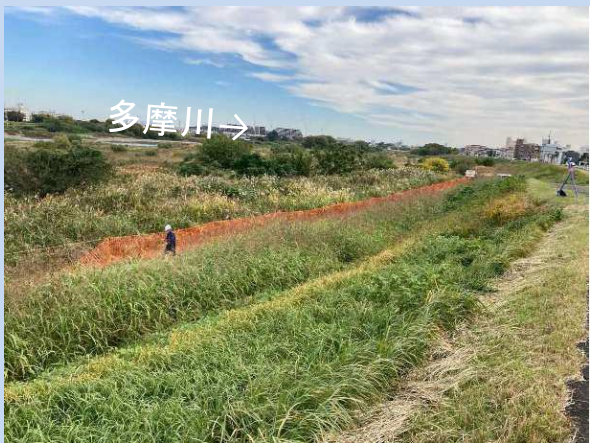
工事に入る準備をしています。 (令和7年11月)
