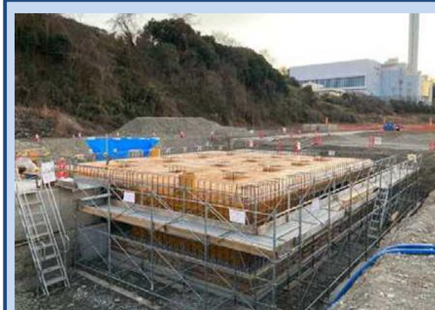
水路を作成するための型枠を組み立てています。 (令和8年1月)
