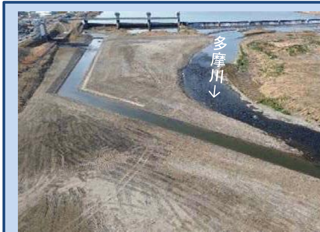
河道の掘削が完了しました。 (令和8年2月)
