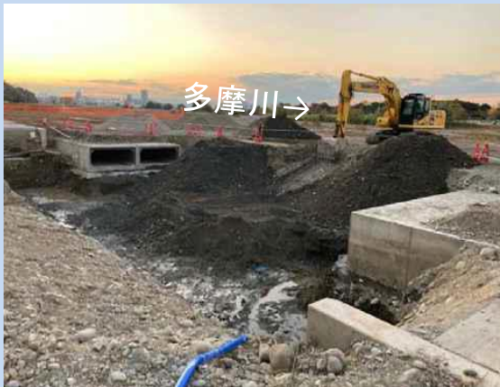
水路を設置するため掘削しています。 (令和7年11月)
