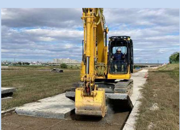
工事に入る準備をしています。 (令和7年10月)
