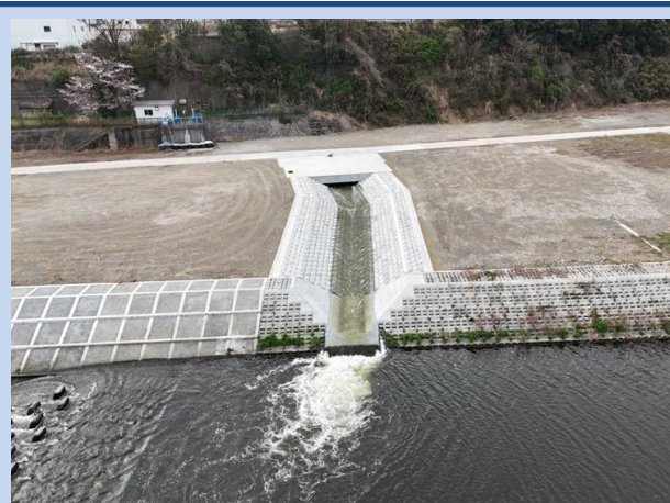
水路が完成しました。 (令和8年3月)
