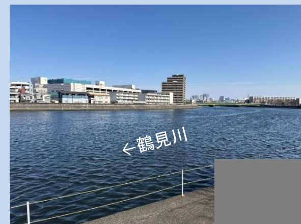
工事が完了しました。 (令和8年3月)
