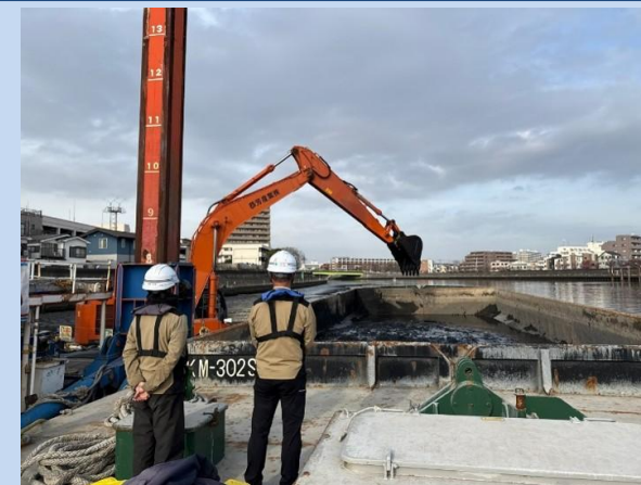
浚渫を行っています。 (令和8年2月)
