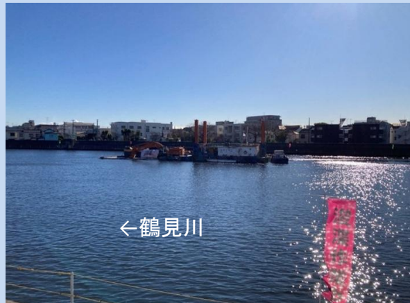
浚渫を行っています。 (令和8年1月)
