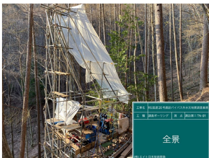
ボーリング実施状況
