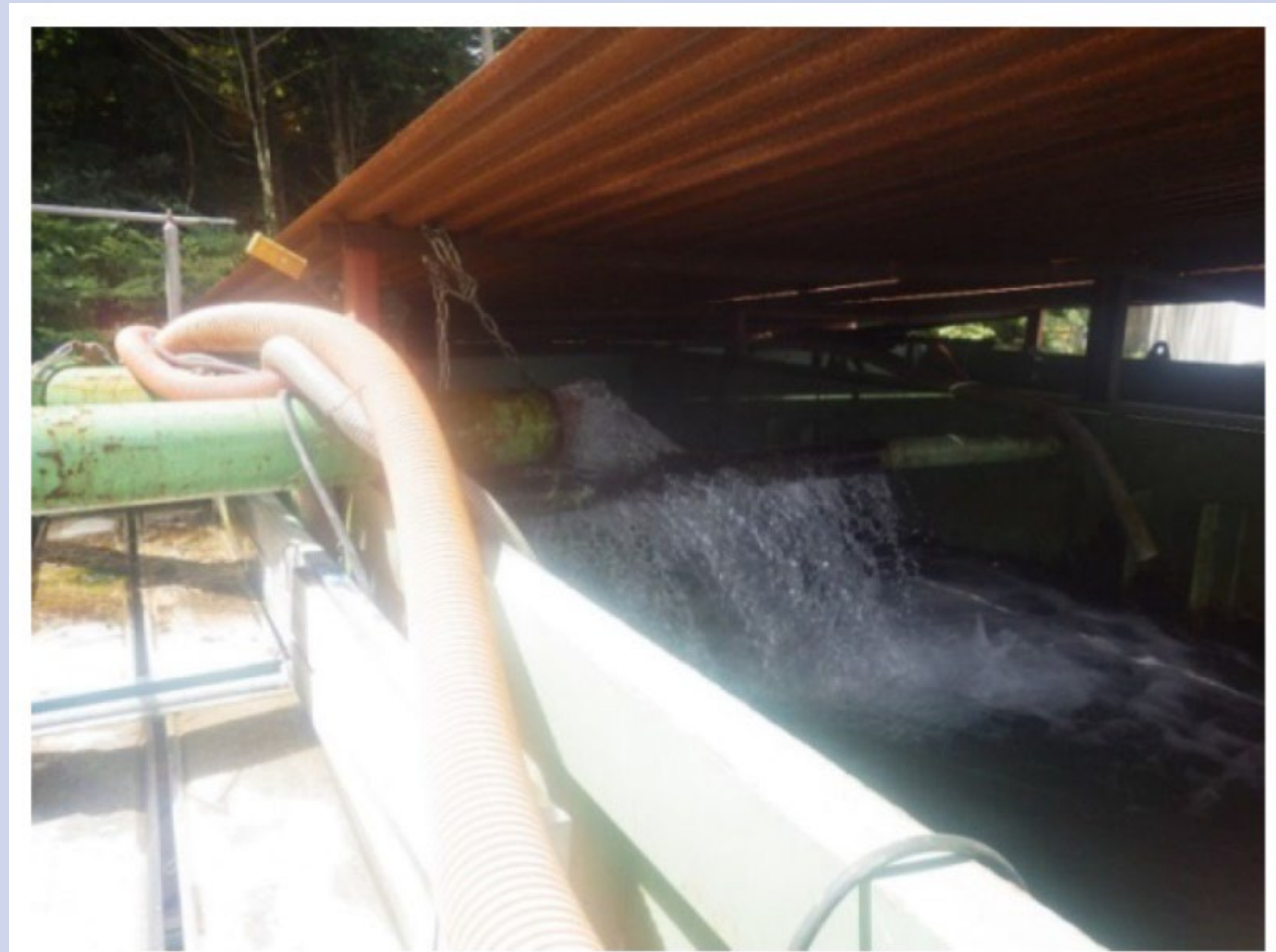
国道41号宮崎トンネル 伊藤 (2019)
