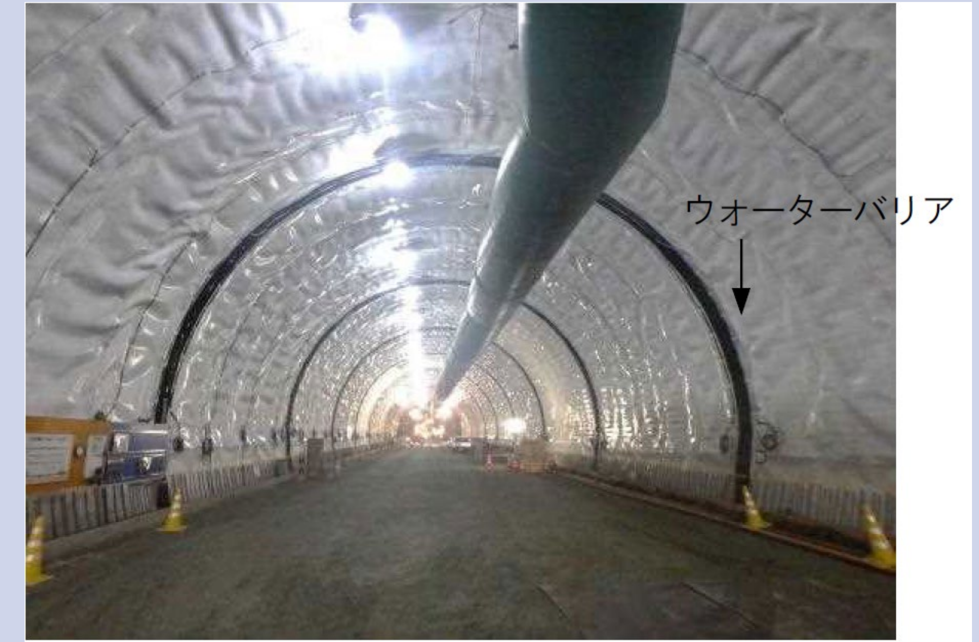
北の峰トンネル 古市ら (2016)
