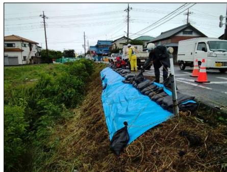
法面陥没対応
