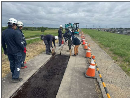
天端亀裂補修
