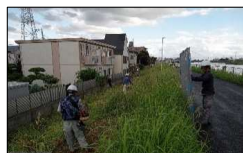
▲除草工事（肩掛け式除草機）
