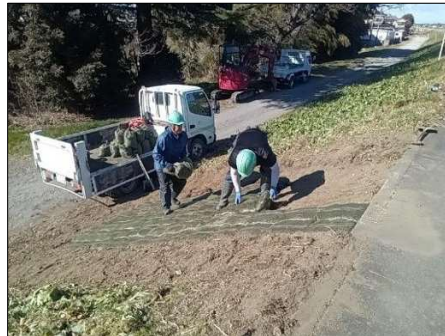
堤防法面への張芝
