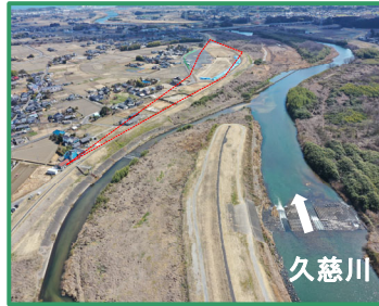
工事箇所の全景 (上流から)
