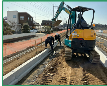
歩車道ブロックを設置しています
