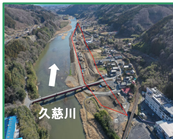
工事箇所の全景 (上流から)
