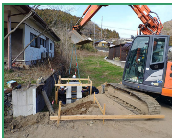
集水枡を設置しています
