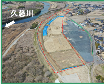
工事箇所の全景 (下流から)
