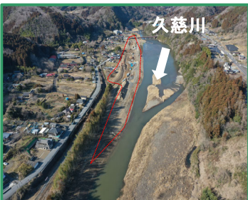
工事箇所の全景 (下流から)
