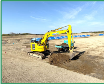
築堤のための表土のすき取りをしています
