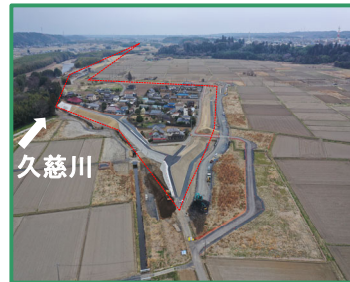
工事箇所の全景 (上流から)
