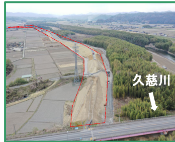
工事箇所の全景 (下流から)
