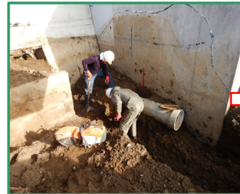
U型側溝を排水施設に接続しています
