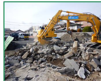
基礎コンクリートを取壊しています
