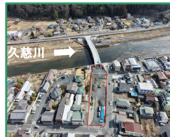
工事箇所の全景 (右岸側から)
