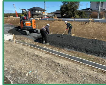
砕石舗装の敷均しをしています
