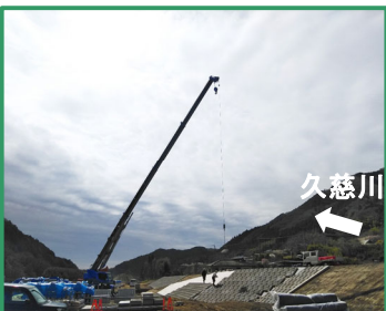
連節ブロックを設置しています
