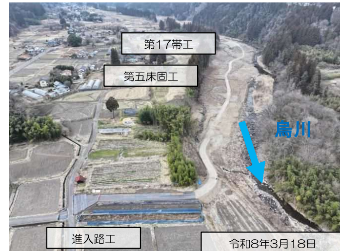
進入路工 下流側から
